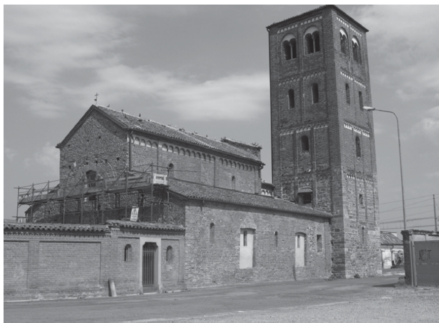
Chiesa del cimitero di Tronzano.
